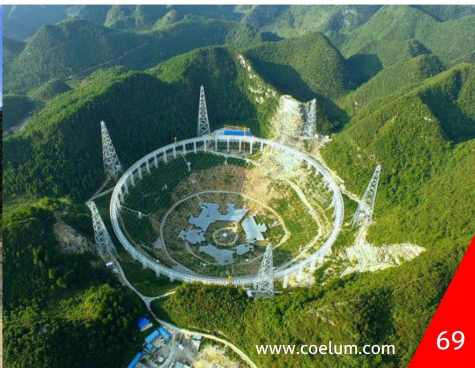
creando la tanto desiderata forma a parabola per concentrare alla perfezione le onde radio nel ricevitore sospeso (molto più piccolo e leggero di quello di Arecibo). La bassa tolleranza dimensionale di costruzione e il controllo certosino permette di modellare la geometria della superficie con uno scarto di precisione di soli 3 mm.
