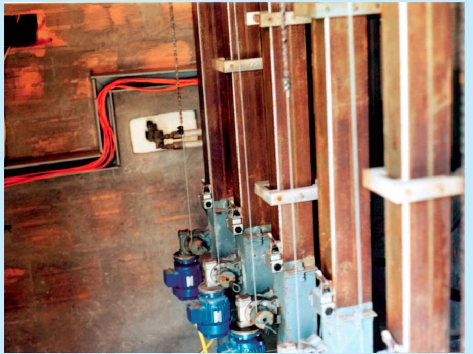
**Sopra.** Il fasatore d'onda a kerosene. Come spiegato, in un'epoca ancora senza computer, i progettisti della Croce del Nord fecero passare attraverso questi contenitori pieni di cherosene i cavi che portavano i segnali radio ricevuti dalle antenne.
